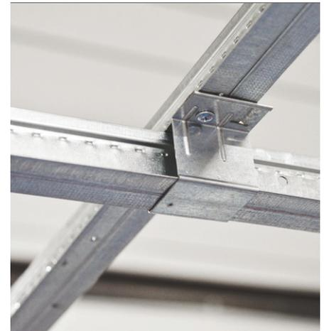
Conçu pour être le moyen le plus rapide et le plus facile d'installer des plafonds en cloisons sèches plats dans les applications de couloir.
