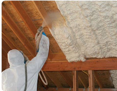
Isolation en mousse pulvérisée
