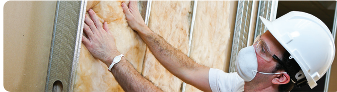
Isolation Certapro MC pour bâtiments commerciaux
