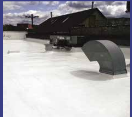
Techos de aplicación líquida
