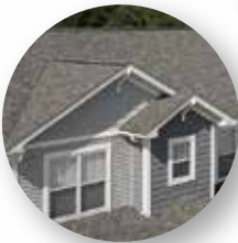
Techos y ventilación
