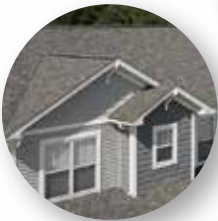
Techos y ventilación
