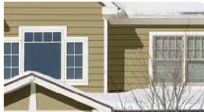
REVESTIMIENTO CON AISLAMIENTO
