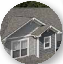
Techos y ventilación
